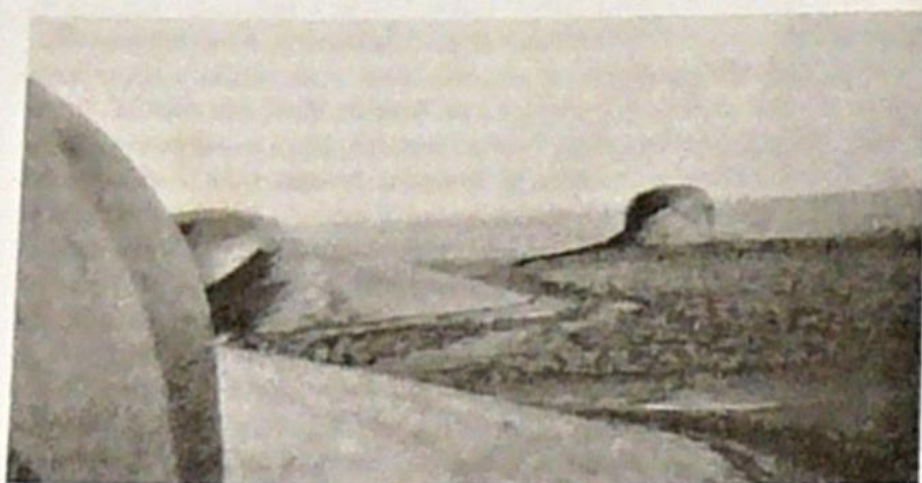
OP S-15 "U Kruhovky" v r. 1939. Zvony s maskovacím nátěrem - prostřední je určen pro dělostř. pozorovatele.
